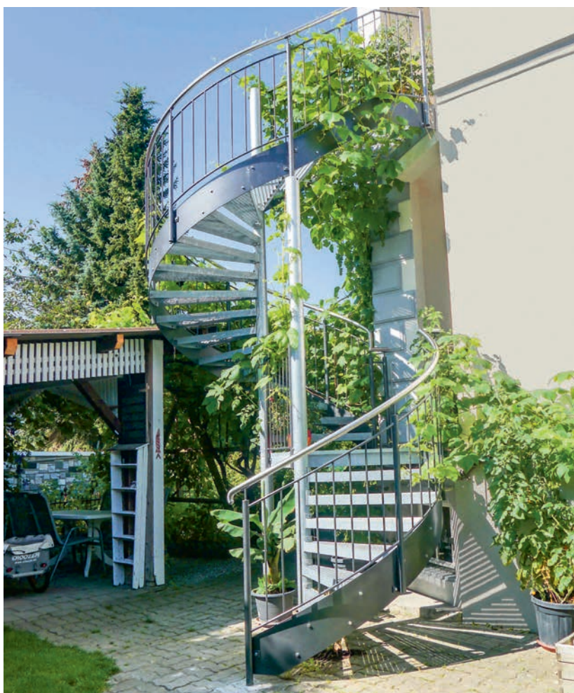
Erstmalig in der Geschichte von Sprich: zwei aufeinanderfolgende, versetzte Spindel- treppen mit anschliessender gerader Treppe.
